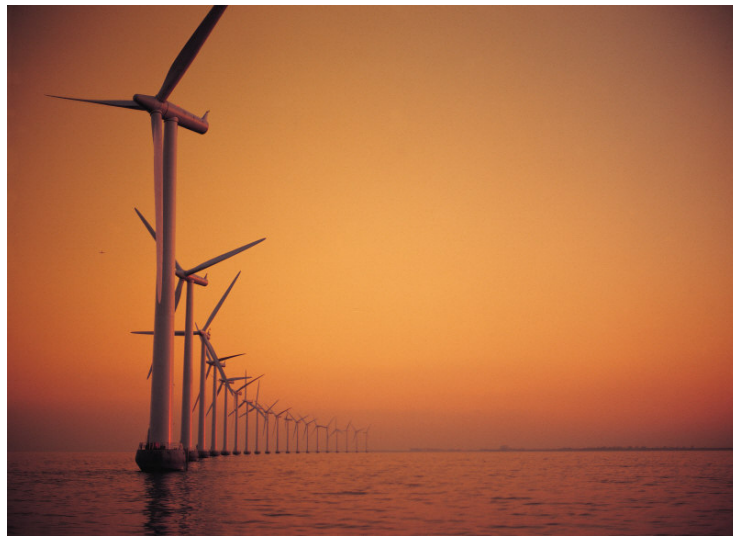
Figura 1: Turbinas eólicas montadas em alto mar
